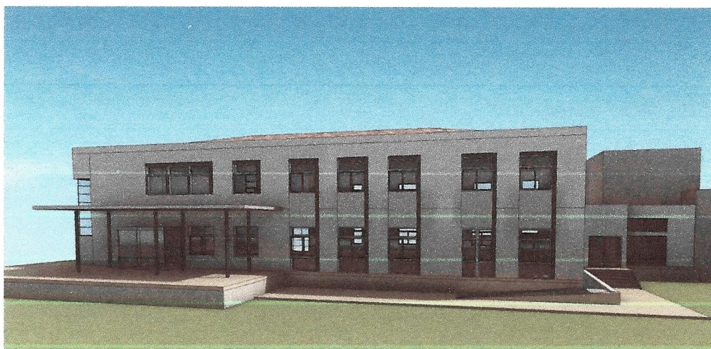
ΝΟΤΙΟΑΝΑΤΟΛΙΚΗ ΑΠΟΨΗ-ΕΙΣΟΔΟΣ ΚΤΙΡΙΟΥ
