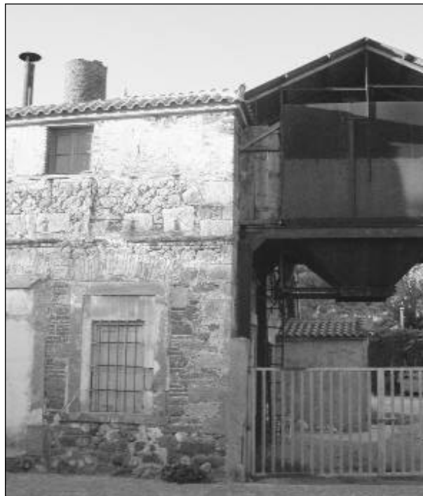
Ελαιοτριβείο Σκάλας Σκαμνιάς
